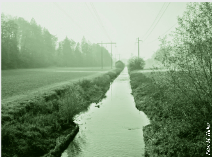
Mit Betonplatten verbauter Bünzabschnitt
