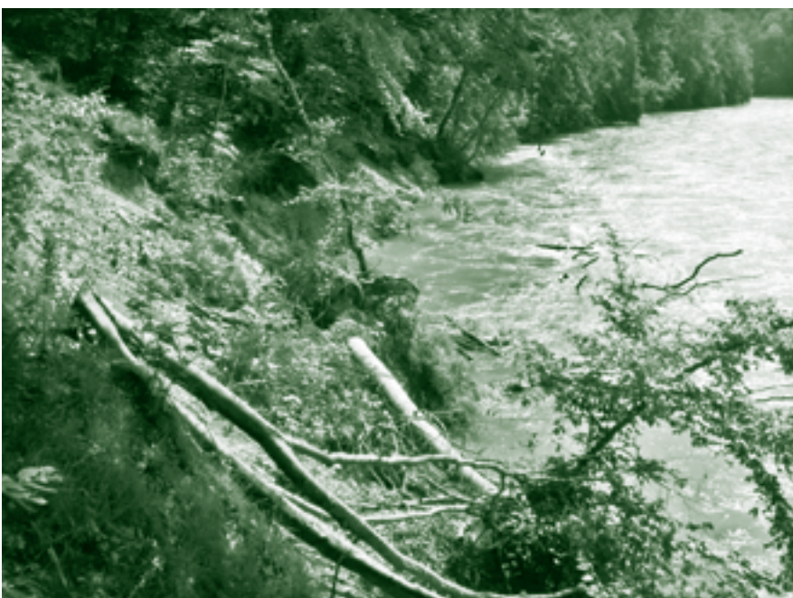
Raubbäume schützen die Reusshalde bei Birmenstorf.
