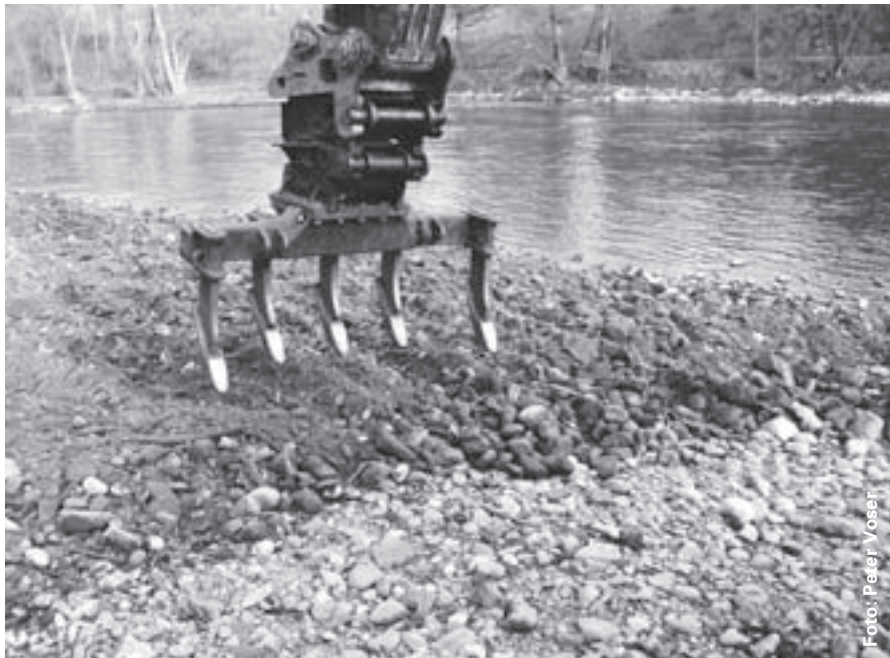
Unterhalb von Bremgarten werden verhärtete Kiesbänke bei tiefem Wasserstand für die Laichzeit vorbereitet.
